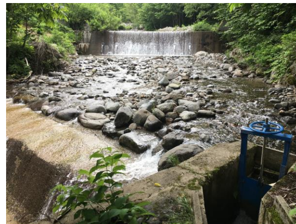
取水堰、取水口の改修（米沢大平）
