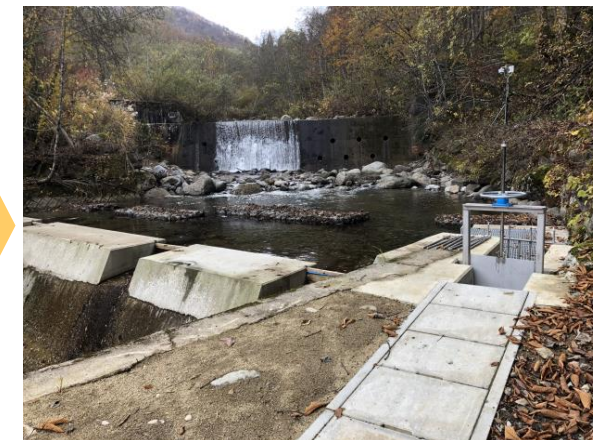
取水堰、取水口の改修（米沢大平）
